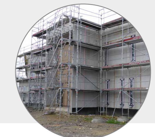
Mit dem Neubau setzt PARA ein positives Zeichen für die Zukunft. Das Gebäude besitzt auch einen Schulungsraum und macht teamorientiertes Arbeiten leicht.
